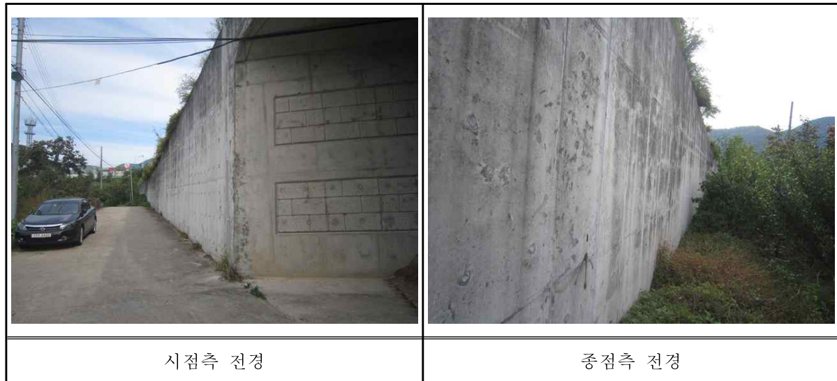
<그림 1.1.1> 콘크리트옹벽(6공구) 전경
